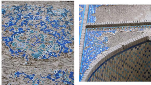
تصویر ۱۰: راست: تلفیقی از کاشی و سفال در تزیین ایوان ورودی مدرسه غیاثیه، چپ: نقش هندسی هشت و مربع صابونی استفاده شده در تزیینات مدرسه غیاثیه، (گلمبک و ویلبر، ۱۳۷۴)
